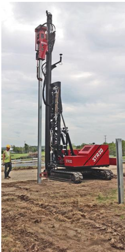
Slika 20. Postavljanje čeličnih greda u zemlju
