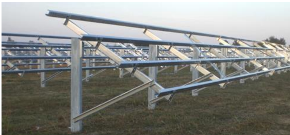
Slika 16. Konstrukcija za fiksni sustav
