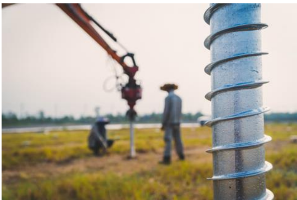
Slika 21. Postavljanje sidrenih vijaka
